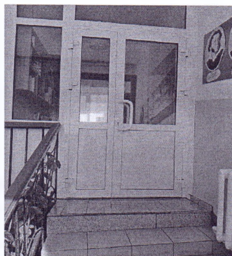
Фото № 4. Дверь на втором этаже
