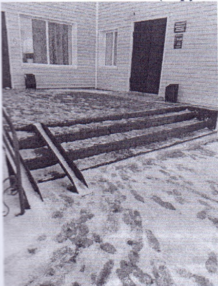
Фото № 1. Лестница (наружная)
