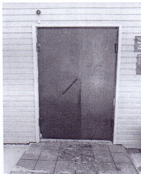
Фото № 4. Входная дверь.
